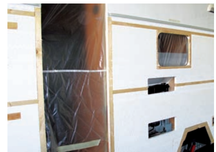
3. Vorbereiteter Caravan für die Neuverblechung
