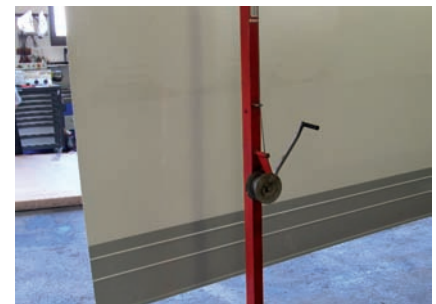
6. Blech aufhängung für die spätere exakte Positionierung
